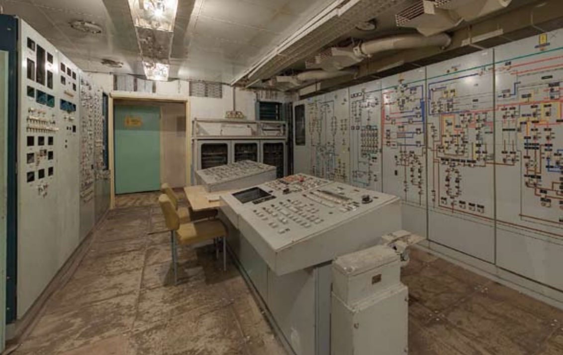
Schaltzentrale des Honecker-Bunkers: rührend dilettantische James-Bond-Kulisse
